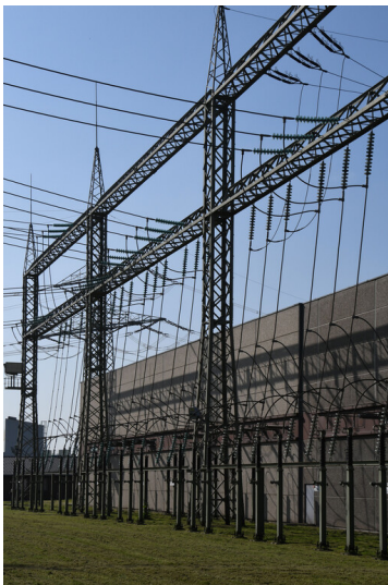
Kraftwerk Goldenberg-Werk: 110-kV-Umspannanlage Knapsack, Abspanngerüst am 110-kV-Schalthaus, Ansicht von Nordwesten; Foto: 25.05.2023 Fotograf/Urheber: Dr. Norbert Gilson
