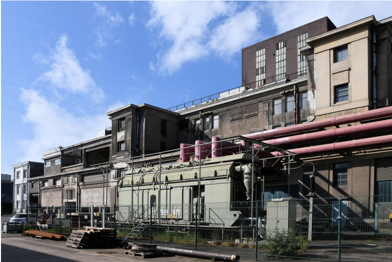
Kraftwerk Goldenberg-Werk: Block-Trafo E (Maschinentransformator für Maschine E) vor dem Schaltanlagenvorbau, Ansicht von Norden; Foto: 25.05.2023 Fotograf/Urheber: Dr. Norbert Gilson
