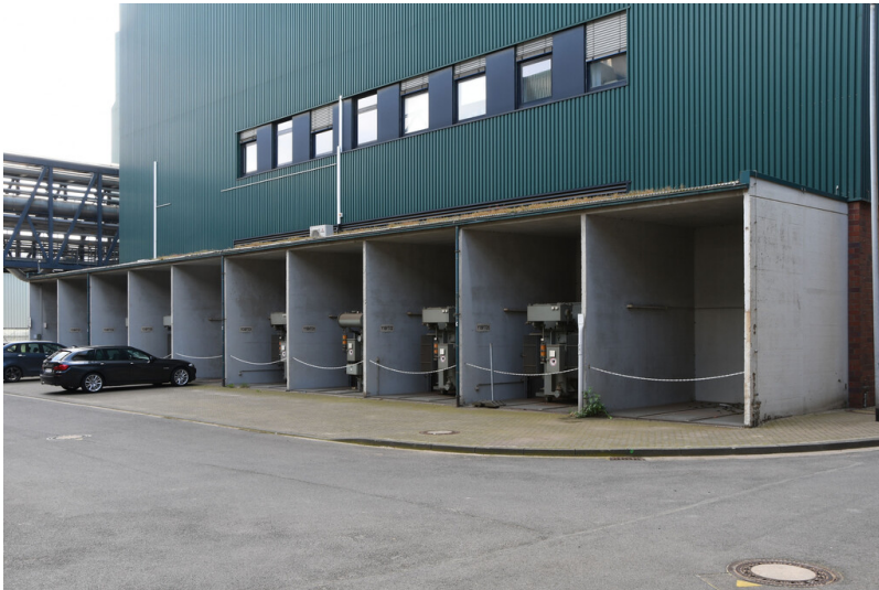
Kraftwerk Goldenberg-Werk: Schaltheis DE J/K, Trafzellen für die Eigenbedarfstransformatoren, Ansicht von Westen; Foto: 25.05.2023 Fotograf/Urheber: Dr. Norbert Gilson
