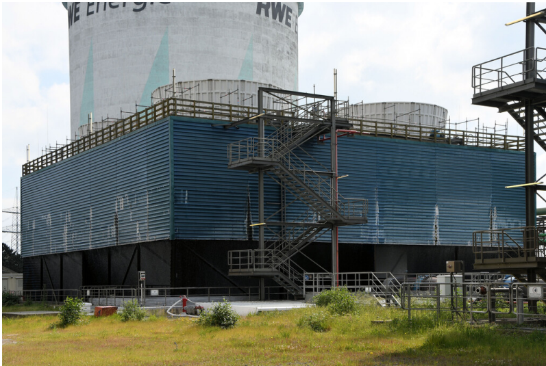
Kraftwerk Goldenberg-Werk: Kühler 2, Ansicht von Südwesten; Foto: 25.05.2023 Fotograf/Urheber: Dr. Norbert Gilson
