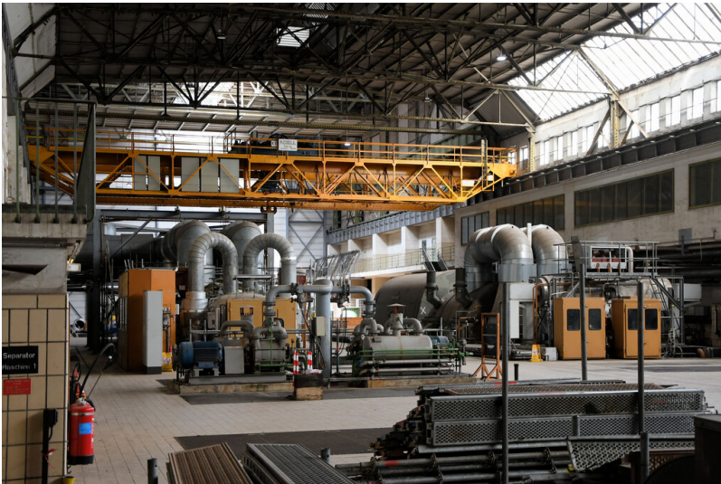
Kraftwerk Goldenberg-Werk: Maschinenhaus I mit den Maschinen E (rechts) und F (links), dahinter Maschinenhaus II sichtbar, Ansicht von Südosten; Foto: 23.05.2023 Fotograf/Urheber: Dr. Norbert Gilson
