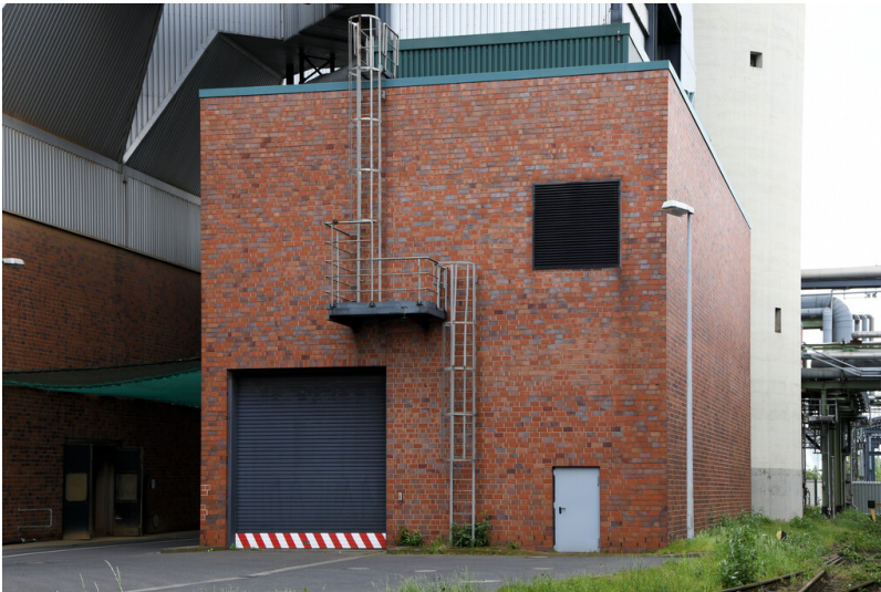
Kraftwerk Goldenberg-Werk: Saugzuggebäude DE-K, Ansicht von Westen; Foto: 23.05.2023 Fotograf/Urheber: Dr. Norbert Gilson
