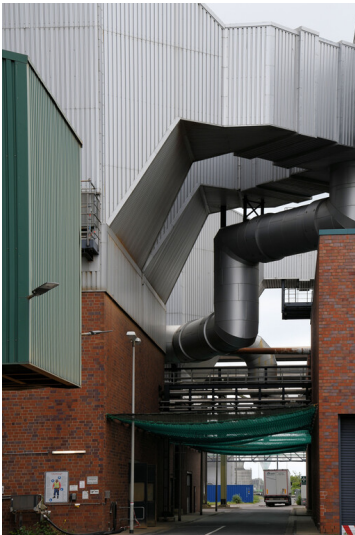
Kraftwerk Goldenberg-Werk: E-Filter K, Ausgangskanäle zum Saugzug DE-K, Ansicht von Nordwesten; Foto: 23.05.2023 Fotograf/Urheber: Dr. Norbert Gilson
