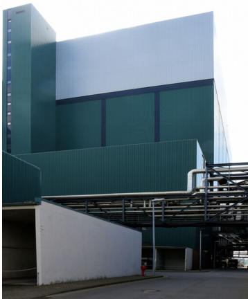
Kraftwerk Goldenberg-Werk: Kesselhaus DE K, Ansicht von Nordwesten; Foto: 25.05.2023 Fotograf/Urheber: Dr. Norbert Gilson
