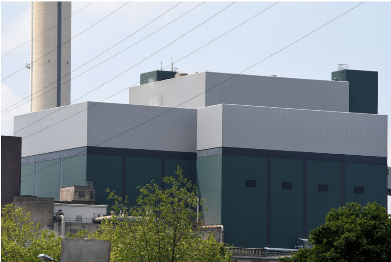
Kraftwerk Goldenberg-Werk: Kesselhaus DE J (links), Ansicht von Osten; Foto: 25.05.2023 Fotograf/Urheber: Dr. Norbert Gilson
