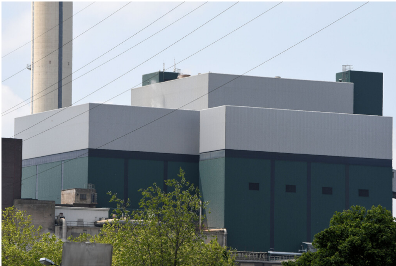
Kraftwerk Goldenberg-Werk: Kesselhaus DE J (links), Ansicht von Osten; Foto: 25.05.2023 Fotograf/Urheber: Dr. Norbert Gilson
