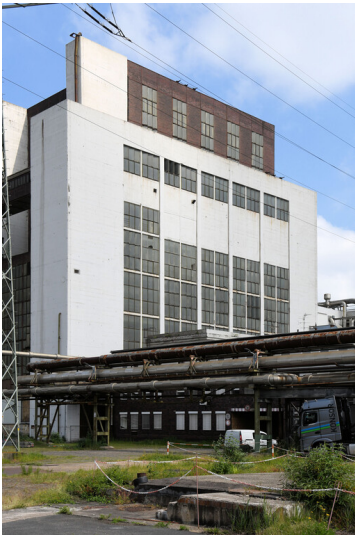
Kraftwerk Goldenberg-Werk: Schwerbau 3 (seitlich des Kesselhauses 1), Ansicht von Süden; Foto: 25.05.2023 Fotograf/Urheber: Dr. Norbert Gilson
