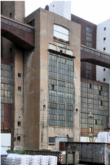
Kraftwerk Goldenberg-Werk: Schwerbau 2 (zwischen den Kesselhäusern 1 und 2), Ansicht von Westen; Foto: 23.05.2023 Fotograf/Urheber: Dr. Norbert Gilson
