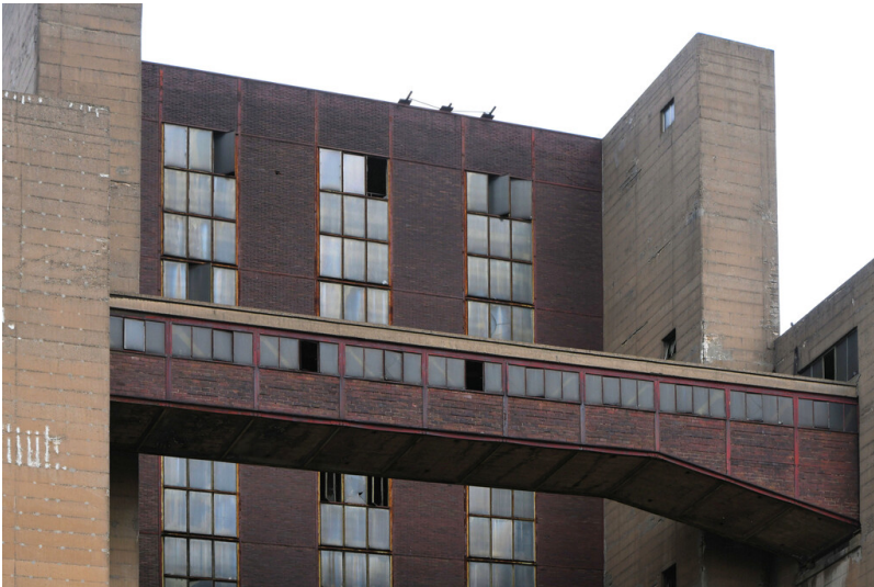
Kraftwerk Goldenberg-Werk: Bekohlungsbandbrücke von Schwerbau 2 (rechts) zum Schwerbau 1 (links), Ansicht von Südwesten; Foto: 23.05.2023 Fotograf/Urheber: Dr. Norbert Gilson
