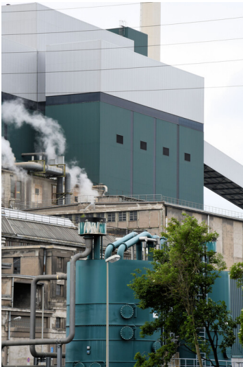
Kraftwerk Goldenberg-Werk: Schwerbau J/K, Ansicht von Südosten; Foto: 23.05.2023 Fotograf/Urheber: Dr. Norbert Gilson
