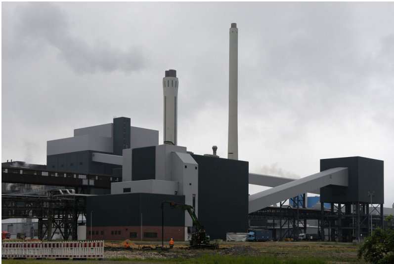
Kraftwerk Goldenberg-Werk: Bekohlungsweg vom PD Brechereigebäude zum PD Bekohlungssekturm (rechte Bildhälfte), Ansicht von Norden; Foto: 23.05.2023 Fotograf/Urheber: Dr. Norbert Gilson
