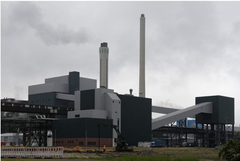
Kraftwerk Goldenberg-Werk: Bekohlungsweg vom PD Brechereigebäude zum PD Bekohlungseckturm (rechte Bildhälfte), Ansicht von Norden; Foto: 23.05.2023 Fotograf/Urheber: Dr. Norbert Gilson
