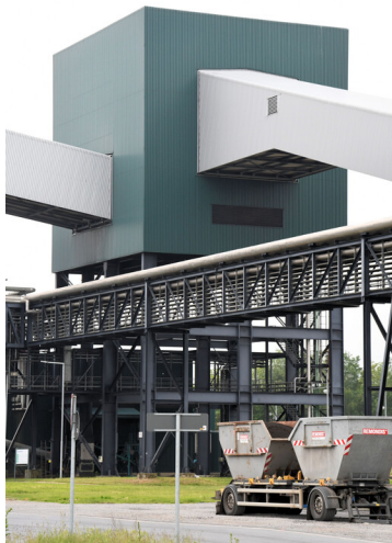
Kraftwerk Goldenberg-Werk: PD Bekohlungsseckturm, Ansicht von Osten; Foto: 23.05.2023 Fotograf/Urheber: Dr. Norbert Gilson
