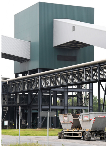
Kraftwerk Goldenberg-Werk: PD Bekohlungsseckturm, Ansicht von Osten; Foto: 23.05.2023 Fotograf/Urheber: Dr. Norbert Gilson
