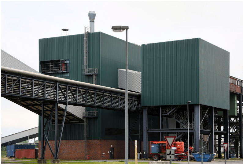
Kraftwerk Goldenberg-Werk: PD Brechereigebäude (links) und Übergabeturm (rechts) mit der Verbindungs-Schrägbandbrücke, Ansicht von Süden; Foto: 23.05.2023 Fotograf/Urheber: Dr. Norbert Gilson
