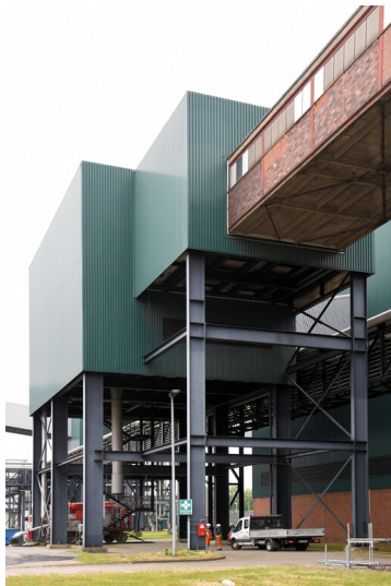
Kraftwerk Goldenberg-Werk: Übergabeturm, Ansicht von Osten; Foto: 23.05.2023 Fotograf/Urheber: Dr. Norbert Gilson
