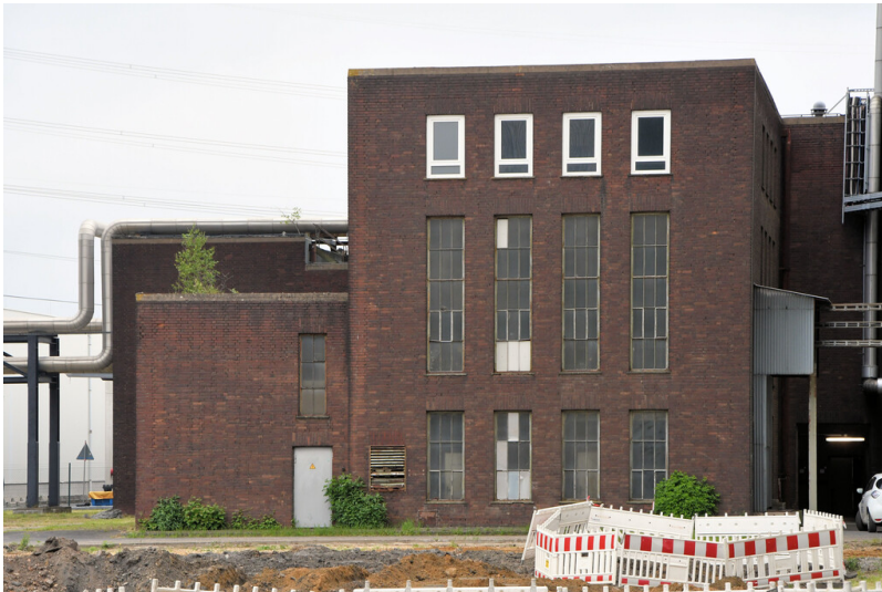
Kraftwerk Goldenberg-Werk: Gebäude C, nordwestlicher Gebäudeflügel mit Schaltanlage und Trafostellen (links), Ansicht von Südwesten; Foto: 23.05.2023 Fotograf/Urheber: Dr. Norbert Gilson
