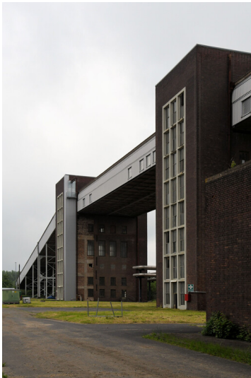
Kraftwerk Goldenberg-Werk: Bekohlungsweg vom Nachbrechergebäude am Grabenbunker Gotteshilfe zum Bekohlungssekturm C, Bekohlungssekturm A und B mit Bandbrücke, Ansicht von Südosten; Foto: 23.05.2023 Fotograf/Urheber: Dr. Norbert Gilson
