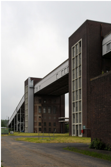
Kraftwerk Goldenberg-Werk: Bekohlungsweg vom Nachbrechergebäude am Grabenbunker Gotteshülfe zum Bekohlungssekturm C, Bekohlungssekturm A und B mit Bandbrücke, Ansicht von Südosten; Foto: 23.05.2023 Fotograf/Urheber: Dr. Norbert Gilson
