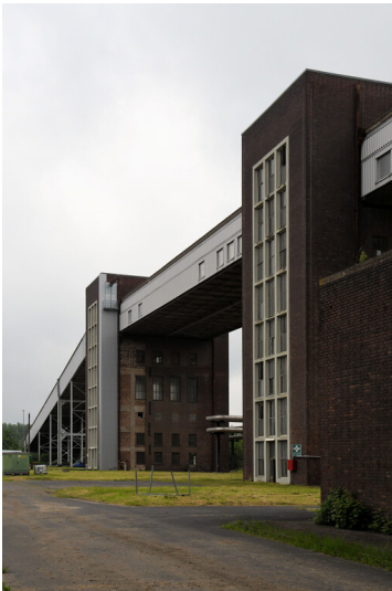
Kraftwerk Goldenberg-Werk: Bekohlungsweg vom Nachbrechergebäude am Grabenbunker Gotteshülfe zum Bekohlungssektorturm C, Bekohlungssektorturm A und B mit Bandbrücke, Ansicht von Südosten; Foto: 23.05.2023 Fotograf/Urheber: Dr. Norbert Gilson
