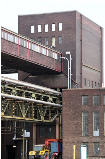
Kraftwerk Goldenberg-Werk: Bekohlungsseckturm C, Ansicht von Süden; Foto: 23.05.2023 Fotograf/Urheber: Dr. Norbert Gilson
