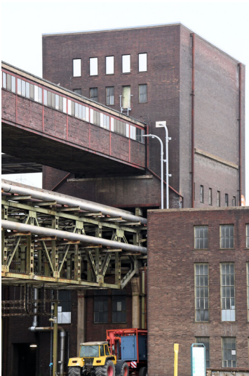
Kraftwerk Goldenberg-Werk: Bekohlungsseckturm C, Ansicht von Süden; Foto: 23.05.2023 Fotograf/Urheber: Dr. Norbert Gilson
