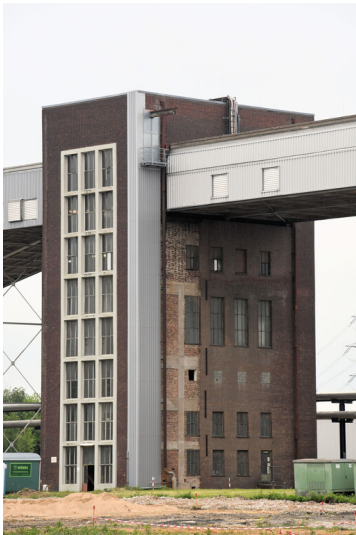
Kraftwerk Goldenberg-Werk: Bekohlungsseckturn A, Ansicht von Süden; Foto: 23.05.2023 Fotograf/Urheber: Dr. Norbert Gilson
