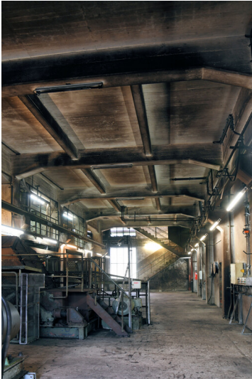
Kraftwerk Goldenberg-Werk: Nachbrechergebäude, Raum für die Aufstellung der Brecher; Foto: 23.05.2023 Fotograf/Urheber: Dr. Norbert Gilson
