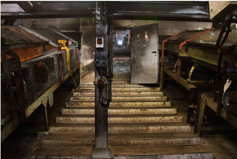
Kraftwerk Goldenberg-Werk: Bandtunnel vom Vorbrechergebäude zum Aufgabebau des Nachbrechergebäudes, Ansicht von Nordosten; Foto: 23.05.2023 Fotograf/Urheber: Dr. Norbert Gilson
