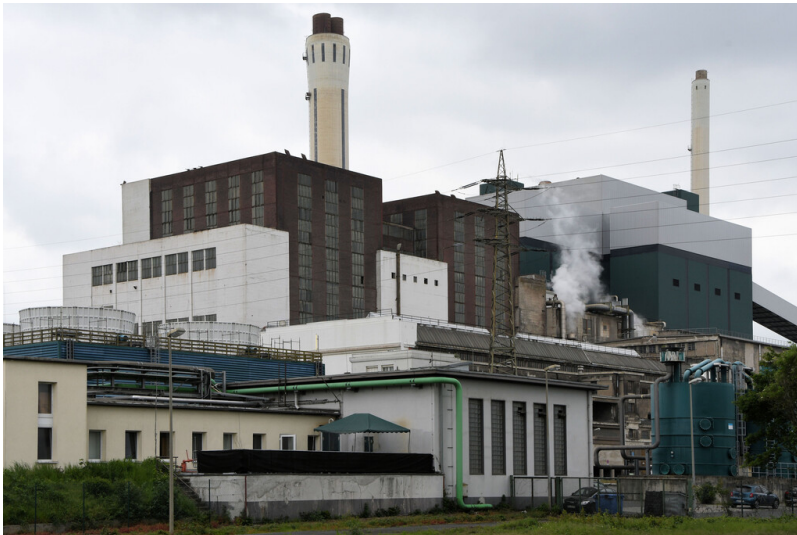
Kraftwerk Goldenberg-Werk: Ansicht von Osten; Foto: 23.05.2023 Fotograf/Urheber: Dr. Norbert Gilson
