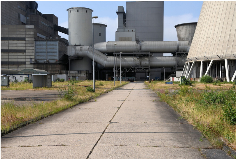
Kraftwerk Frimmersdorf II: Kühlturmstraße 3, Ansicht von Norden; Foto: 23.06.2023 Fotograf/Urheber: Dr. Norbert Gilson
