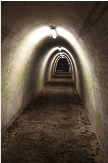
Kraftwerk Frimmersdorf II: Fußgängertunnel, Ansicht von Norden; Foto: 22.03.2023 Fotograf/Urheber: Dr. Norbert Gilson
