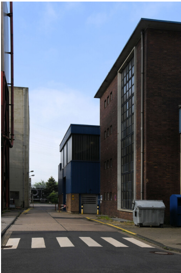
Kraftwerk Frimmersdorf II: Werkstraße, zwischen Lager/Werkstatt I und Bekohlungsbandbrücke hindurchführend, Ansicht von Norden; Foto: 23.06.2023 Fotograf/Urheber: Dr. Norbert Gilson
