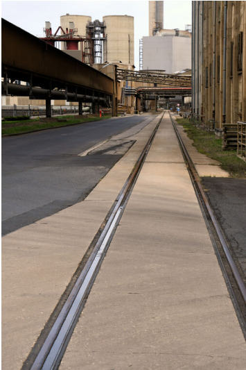
Kraftwerk Frimmersdorf II: Werkstraße 8, westlich von Aschehochbunker A/O parallel zum Aschegleis verlaufend, Ansicht von Süden; Foto: 22.03.2023 Fotograf/Urheber: Dr. Norbert Gilson
