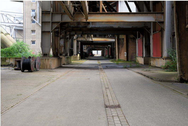
Kraftwerk Frimmersdorf II: Werkstraße (Kaminstraße), zwischen den Schornstein-Fundamentsockeln und den Kühlwasser-Pumpenhäusern verlaufend, Ansicht von Süden; Foto: 23.06.2023 Fotograf/Urheber: Dr. Norbert Gilson
