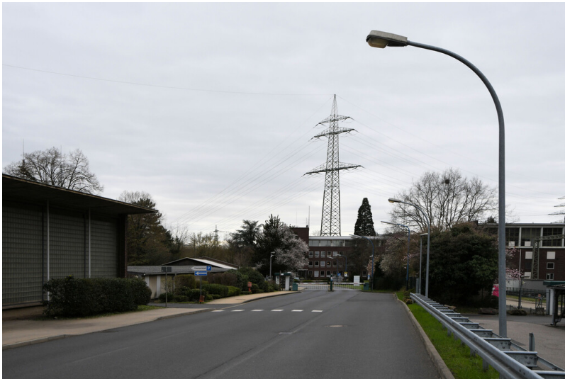
Kraftwerk Frimmersdorf II: Zufahrt vom Pfortnerhaus zum Kraftwerksgelände, Ansicht von Norden; Foto: 22.03.2023 Fotograf/Urheber: Dr. Norbert Gilson
