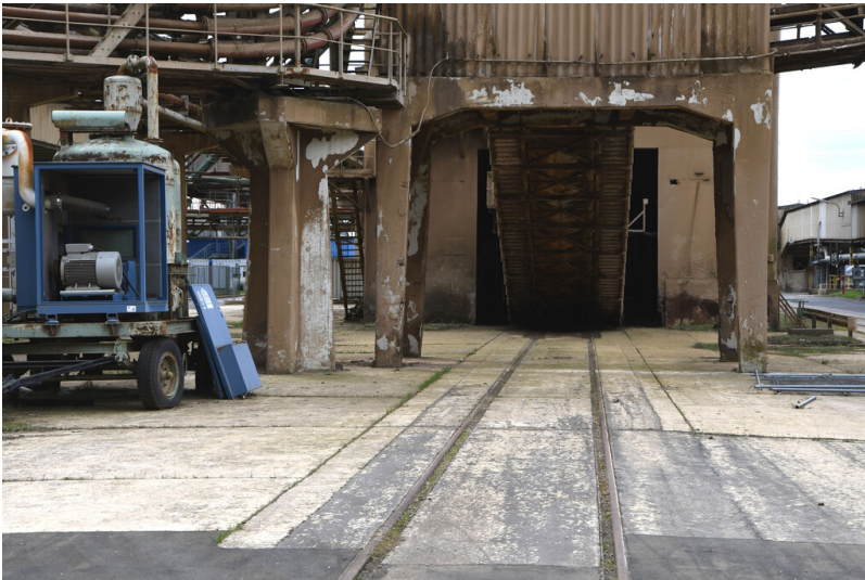
Kraftwerk Frimmersdorf II: Werkgleis, Stichgleis zur ehemaligen Zugverladeanlage im Aschehochbunker A/O, Ansicht von Nordwesten; Foto: 22.03.2023 Fotograf/Urheber: Dr. Norbert Gilson
