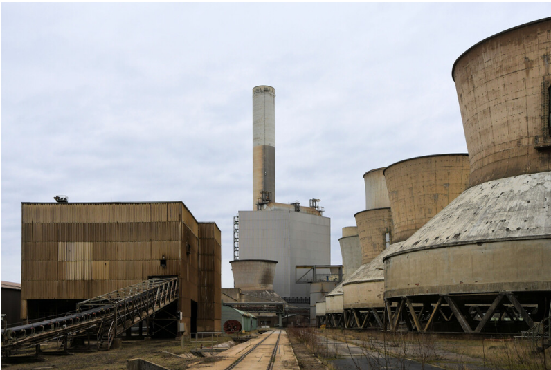
Kraftwerk Frimmersdorf II: Aschegleis, zum Abzweig des Stichgleises zur Asche-Waggonverladung führend, Ansicht von Südwesten; Foto: 22.03.2023 Fotograf/Urheber: Dr. Norbert Gilson
