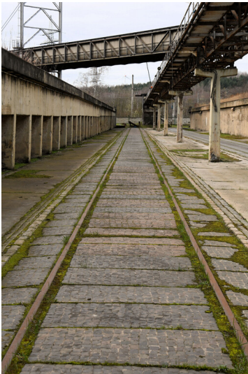
Kraftwerk Frimmersdorf II: Werkgleis, ehemaliges Ascheverladegleis von Ascheabsetzbecken 1 (I-III), Ansicht von Nordosten; Foto: 22.03.2023 Fotograf/Urheber: Dr. Norbert Gilson
