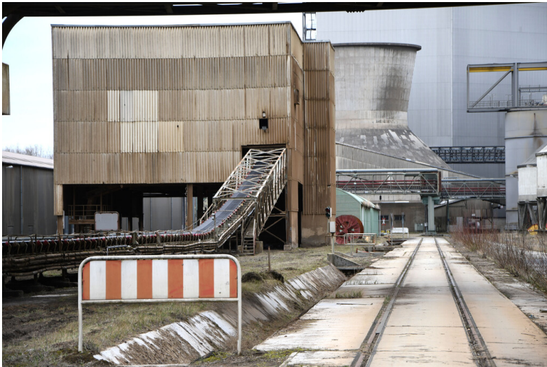
Kraftwerk Frimmersdorf II: Werkgleis, Aschegleis, an der Asche-Waggonverladung vorbei führend, Ansicht von Südwesten; Foto: 22.03.2023 Fotograf/Urheber: Dr. Norbert Gilson
