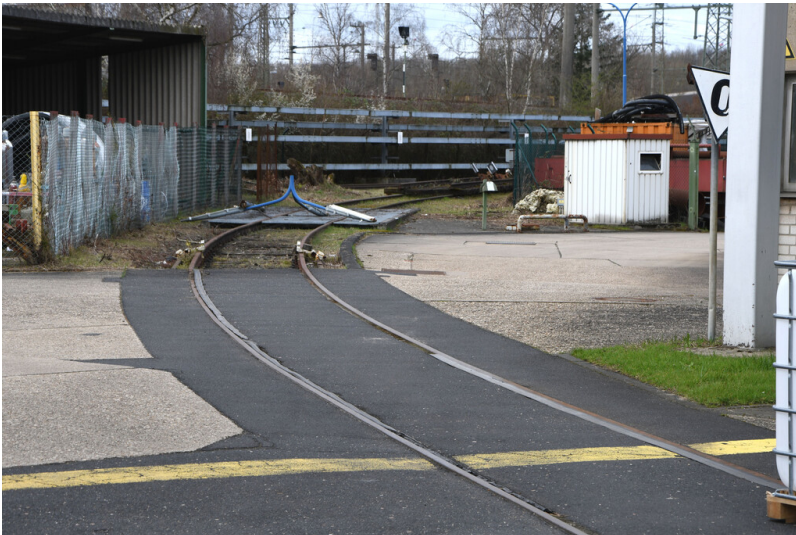
Kraftwerk Frimmersdorf II: Kamingleis, aus Richtung Anschlussgleis von der Nord-Süd-Bahn heranzuführend, Ansicht von Osten; Foto: 22.03.2023 Fotograf/Urheber: Dr. Norbert Gilson
