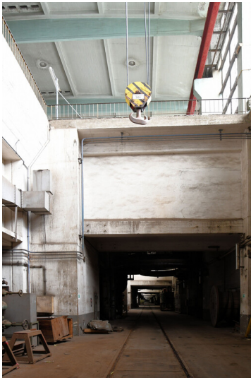
Kraftwerk Frimmersdorf II: Maschinenhausgleis, Verlauf im Maschinenhaus Block B, Ansicht von Süden; Foto: 21.03.2023 Fotograf/Urheber: Dr. Norbert Gilson
