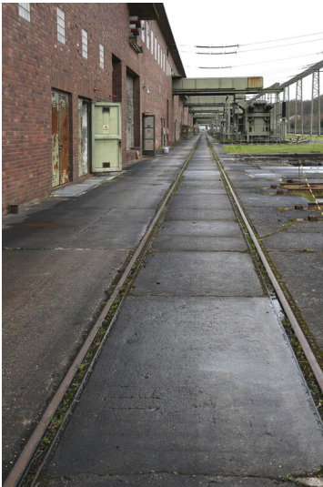
Kraftwerk Frimmersdorf II: Trafogleis vor dem Schaltanlagenvorbau A/O, Ansicht von Süden; Foto: 21.03.2023 Fotograf/Urheber: Dr. Norbert Gilson
