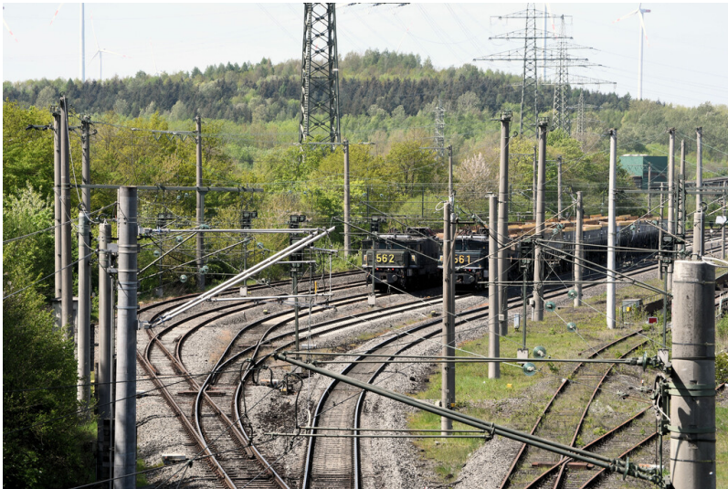
Kraftwerk Frimmersdorf II: Bahnhof Frimmersdorf, südliche Vorbeifahrgleise am Grabenbunker 1, Ansicht von Nordosten; Foto: 04.05.2023 Fotograf/Urheber: Dr. Norbert Gilson
