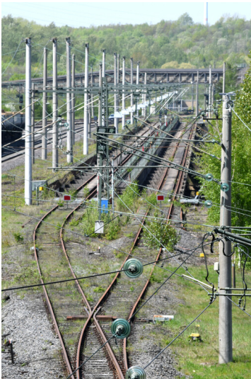
Kraftwerk Frimmersdorf II: Bahnhof Frimmersdorf, Zufahrtsgleise und auf den Betonkragarmen verlaufende Bunkergleise, Ansicht von Osten; Foto: 04.05.2023 Fotograf/Urheber: Dr. Norbert Gilson
