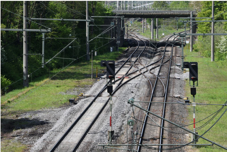
Kraftwerk Frimmersdorf II: Weichenpaar vor dem Gleisanschluss an den Bahnhof Frimmersdorf, Ansicht von Osten; Foto: 04.05.2023 Fotograf/Urheber: Dr. Norbert Gilson
