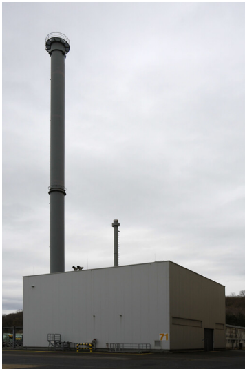
Kraftwerk Frimmersdorf II: Hilfsdampferzeuger, Dampferzeugergebäude und Kamin, Ansicht von Westen; Foto: 22.03.2023 Fotograf/Urheber: Dr. Norbert Gilson
