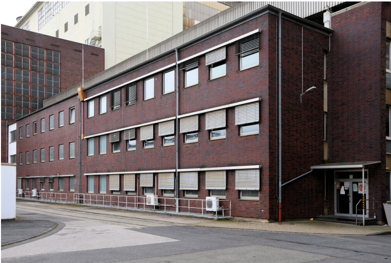
Kraftwerk Frimmersdorf II: Sozialgebäude, Ansicht von Nordosten; Foto: 21.03.2023 Fotograf/Urheber: Dr. Norbert Gilson
