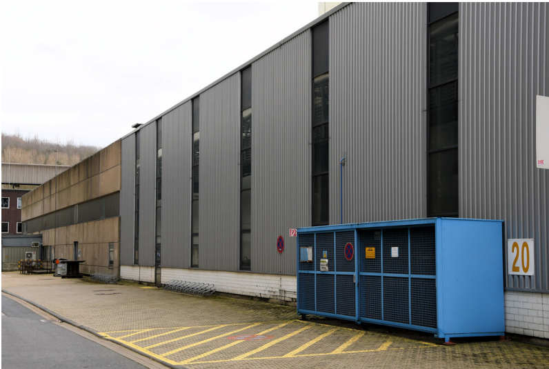
Kraftwerk Frimmersdorf II: Hauptwerkstatt II, Ansicht von Nordwesten; Foto: 22.03.2023 Fotograf/Urheber: Dr. Norbert Gilson
