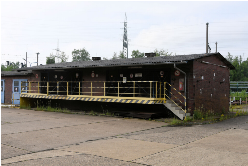
Kraftwerk Frimmersdorf II: Freilager, westlicher Gebädetrakt mit Verladerrampe, Ansicht von Norden; Foto: 23.06.2023 Fotograf/Urheber: Dr. Norbert Gilson
