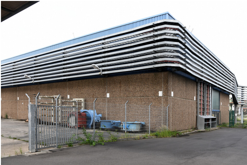
Kraftwerk Frimmersdorf II: Außenlager, Ansicht von Nordosten; Foto: 23.06.2023 Fotograf/Urheber: Dr. Norbert Gilson
