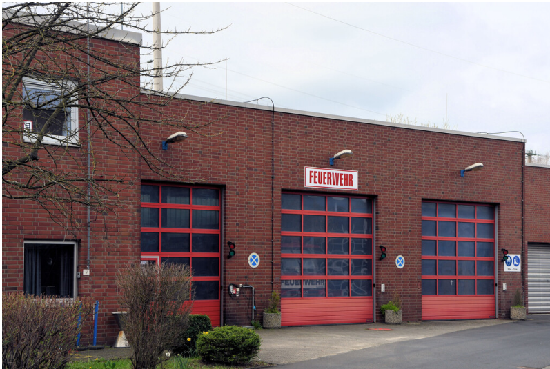
Kraftwerk Frimmersdorf II: Feuerwehrgebäude, Detailansicht von Nordosten; Foto: 22.03.2023 Fotograf/Urheber: Dr. Norbert Gilson
