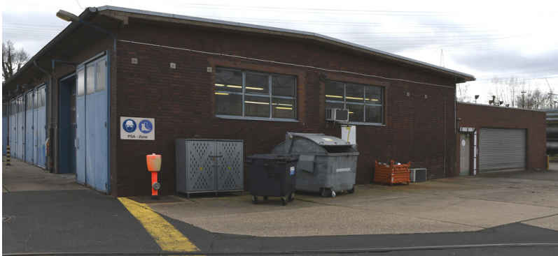
Kraftwerk Frimmersdorf II: Garagen / Kfz-Werkstatt, Ansicht von Nordwesten; Foto: 22.03.2023 Fotograf/Urheber: Dr. Norbert Gilson
