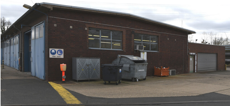
Kraftwerk Frimmersdorf II: Garagen / Kfz-Werkstatt, Ansicht von Nordwesten; Foto: 22.03.2023 Fotograf/Urheber: Dr. Norbert Gilson
