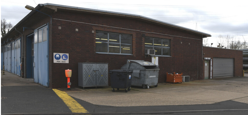
Kraftwerk Frimmersdorf II: Garagen / Kfz-Werkstatt, Ansicht von Nordwesten; Foto: 22.03.2023 Fotograf/Urheber: Dr. Norbert Gilson
