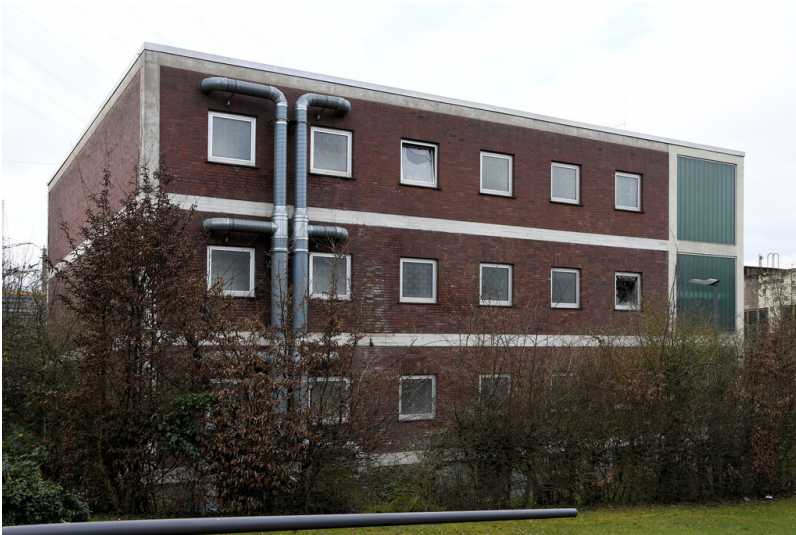
Kraftwerk Frimmersdorf II: Sozialgebäude, Ansicht von Nordosten; Foto: 22.03.2023 Fotograf/Urheber: Dr. Norbert Gilson
