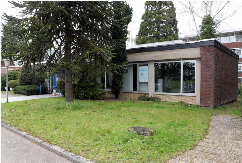
Kraftwerk Frimmersdorf II: Betriebsratsgebäude, Ansicht von Südosten; Foto: 22.03.2023 Fotograf/Urheber: Dr. Norbert Gilson
